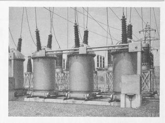
Abb. 9. 150 000 V-Oelschalter im Unterwerk Grynau der N. O. K.
