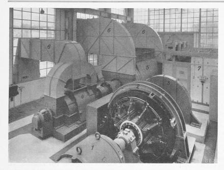
Abb. 11. Maschinenhalle der Kurzschluss-Prüfanlage der M. F. O. — 1 Erreger-Antriebmotor 560 kW; 2 Erregermaschine 8000 A, 1000 V; 3 Schwungrad; 4 Antriebmotor 1700 kW; 5 Kurzschluss-Generator für 1 Million kVA bei 1500 U/min; 6 Frischluft; 7 Kabine mit Umschaltschienen und Drosselspulen.
