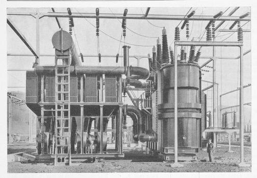
Abb. 5. Transformator für 35 000 kVA des Kraftwerks Ryburg-Schwörstadt. (Vergl. "SBZ" Bd. 99, April/Juni 1932.)
