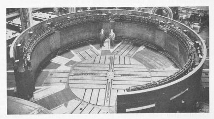
Abb. 4. Stator des 45 000 kVA-Generators des Wasserkraftwerks Beauharnois, Canada.
