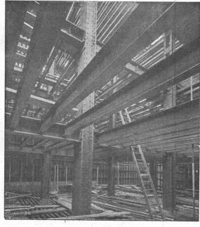
Tresorkonstruktion eines Bankgebäudes
