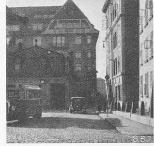
Abb. 3. Blick vom Kasinoplatz westlich auf Engpass und Hauptwache.
