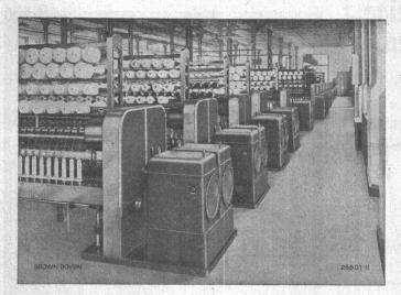
Antrieb von doppelten Baumwoll-Ringspinnmaschinen mit Dreiphasen-Kommutatormotoren.
