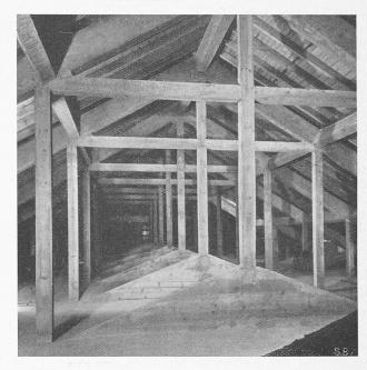
Abb. 4. Ansicht des durch Riegeleinbau verstärkten Dachstuhls.
