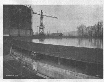
100 000 m³ Gasbehälter Schlieren-Zürich. Dichtigkeitsprobe des Bodens von 2500 m².
