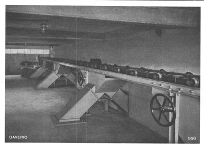
Oberer Becherstrang eines Kohlen-Conveyors mit Silo-Füllvorrichtung
