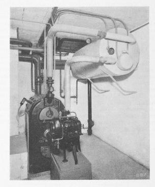
Abb. 1. Vollautomat. Düsen-Oelfeuerung Quiet May, mit W.-W. Boiler.
