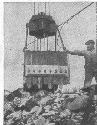
Verwendung von Stahldrahtseilen in Greifbaggern.
