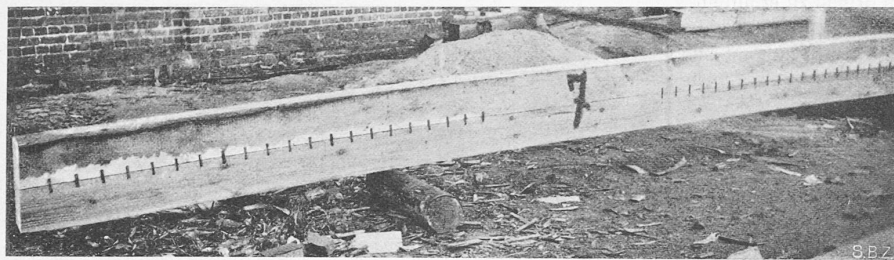
Abb. 1. Mit Hartholzplättchen unter Vorspannung verdübelter, unverbolzter Balken, System Derewiagin.
