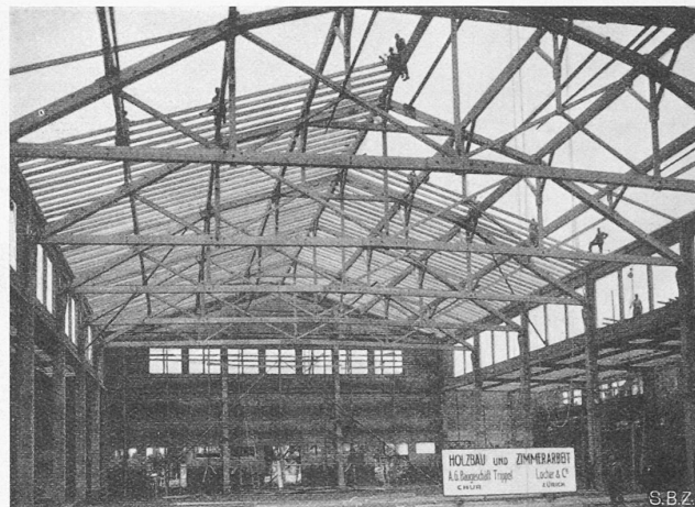
Abb. 10. Montage des hölzernen Hallendaches.
