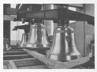
Abb. 4. Montage der Glocken aus der Glockengiesserei Rüetschi & Cie., Aarau.
