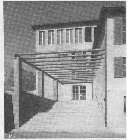
Abb. 3. Aufgang zum Saalbau (Turnhalle).
