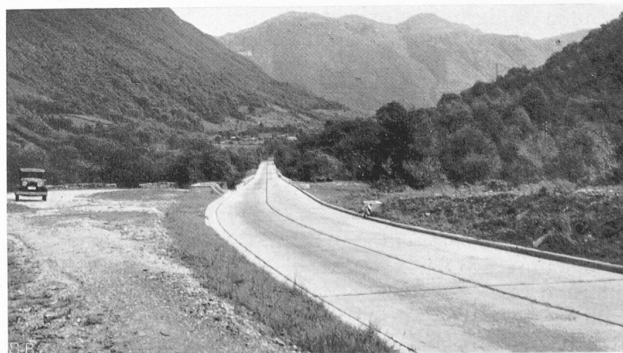
Abb. 10. Betonstrasse mit Griffbelag Ceneri Südrampe, bis 9% Neigung.
