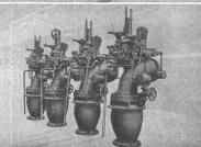
Oben: Drosselklappe 3200 mm Nennweite. Anlage in der Schweiz. Unten: Schnellschluss-Schleber 45 at Druck, Pumpspeicherwerk in Italien.
