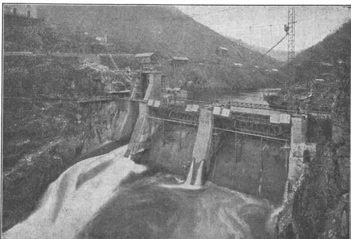
Wehranlage La Cadene an der Truyere, zwei automatische Segmentschützen je 18 X 6 m.
