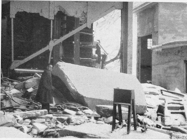
Abb. 2. Etwa 12 t schweres Stück der Betonabdeckung des geplatzten Rohres, 45 m weit in die Transformatoren-Zelle III geschleudert.
