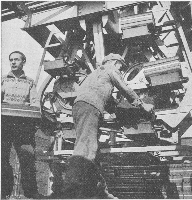
Abb. 8. Entladen der Becherkette im Bahnwagen.
