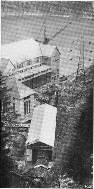
Abb. 23 und 24. Provisorische Rohr-Montagehalle zwischen Stolleneinde und Verteilung.
