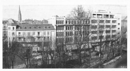
Abb. 1. Ostfront an der Gessnerallee (vorn rechts der Schanzengraben). Links das alte Haus, Mitte Erweiterungsbau 1928 (= 1. Bauabschnitt), rechts Neubau 1932 (= 11. Bauabschnitt).
