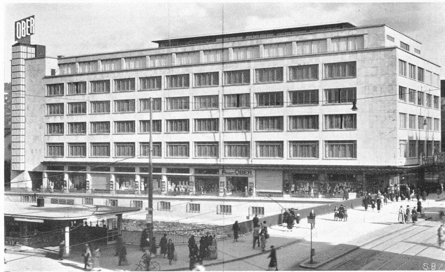
Abb. 2. Gesamtbild aus Südwesten, rechts der Haupteingang an der Sihlstrasse (Sihlbrücke).
