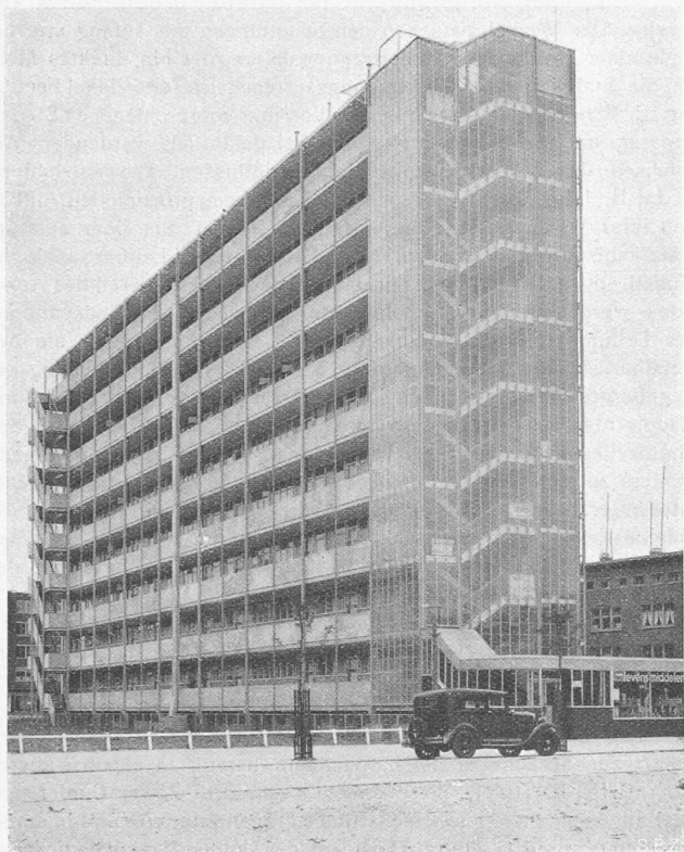
Abb. 10. Nördliches Treppenhaus und Laubengänge der Ostfront.
