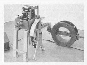
Abb. 6. Elektrischer Antrieb der Einlaufklappe.
