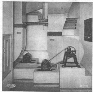
Ventilatorenraum einer größeren Lüftungsanlage. Alle beweglichen Teile und die Luftkanäle sind leicht zugänglich. Gehäuseventilatoren mit hohem Wirkungsgrad und geräuschlosem Gang. Segeltuchstutzen am Ein- und Austritt des Ventilators, sowie Korkisolierung der Fundamente zur Verhütung von Schwingungen und Erschütterungen. Luftdicht schließende Kontrolltüre ermöglicht bequemen Zugang zu den Staubfiltern.
