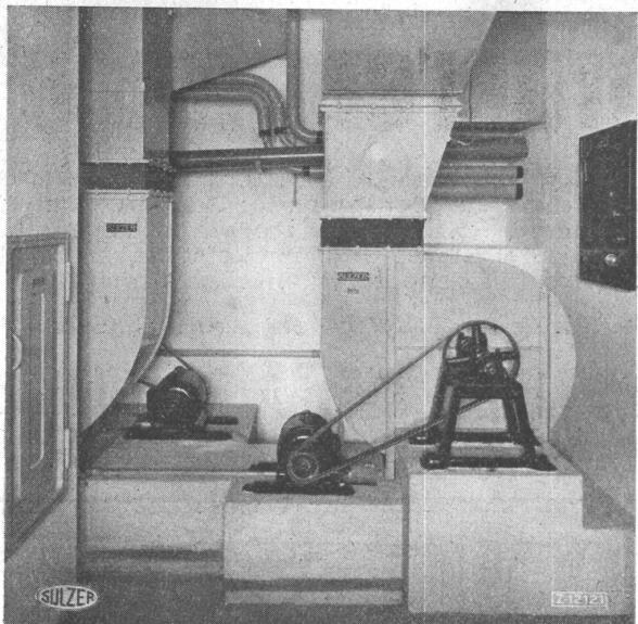
Ventilatorenraum einer größeren Lüftungsanlage. Alle beweglichen Teile und die Luftkanäle sind leicht zugänglich. Gehäuseventilatoren mit hohem Wirkungsgrad und geräuschlosem Gang. Segeltuchstutzen am Ein- und Austritt des Ventilators, sowie Korkisolierung der Fundamente zur Verhütung von Schwingungen und Erschütterungen. Luftpicht schließende Kontrolltüre ermöglicht bequemen Zugang zu den Staubfiltern.
