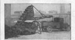
Die Einschaltung zuverlässig arbeitender Gurtförderer ,RACO', auf Raupenbänder laufender Becherwerksauflader oder anderer Fördergeräte, die wir als Spezialität liefern, vermag bei Steigerung der Leistungsfähigkeit die Transportkosten bedeutend zu reduzieren.
