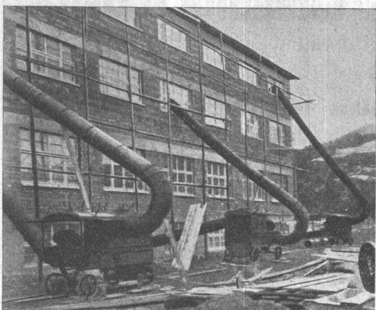
Pat. Druckluft-Verfahren / Ventilier-Trockenöfen / Flecken-Trockner / Austrocknungen in 3 bis 4 Tagen / Beseitigung von Wasserschäden, Schimmelbildung und Hausschwamm
