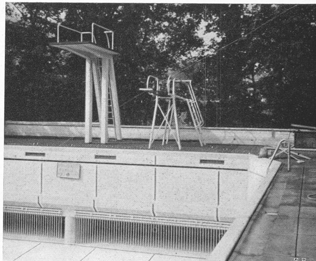
Abb. 12. Wellenaustritt am Tiefende des Schwimmbeckens.
