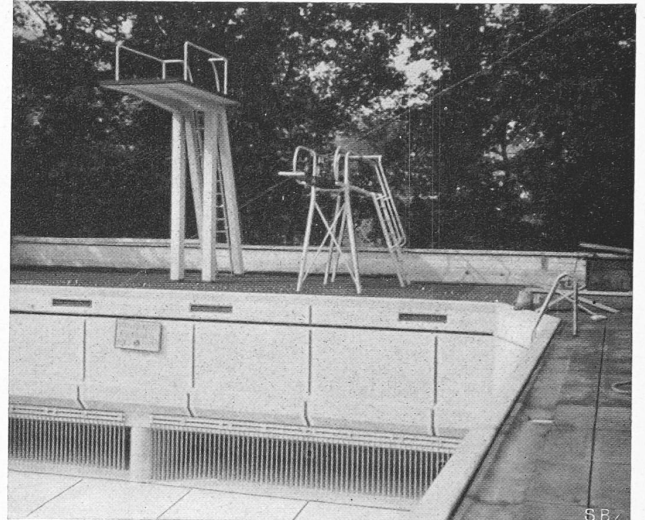
Abb. 12. Wellenaustritt am Tiefende des Schwimmbeckens.
