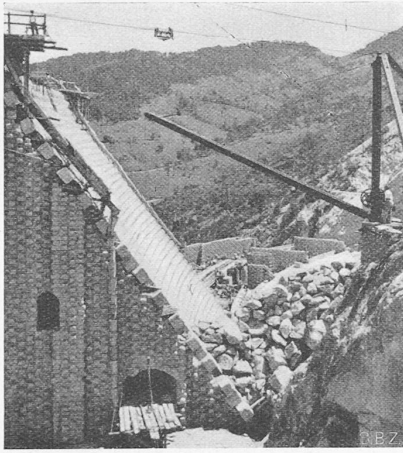
Abb. 7 und 8. Tranco de Beas-Mauer. Transportanlagen, wasser- und luftseitige Verkleidung mit Betonsteinen.
