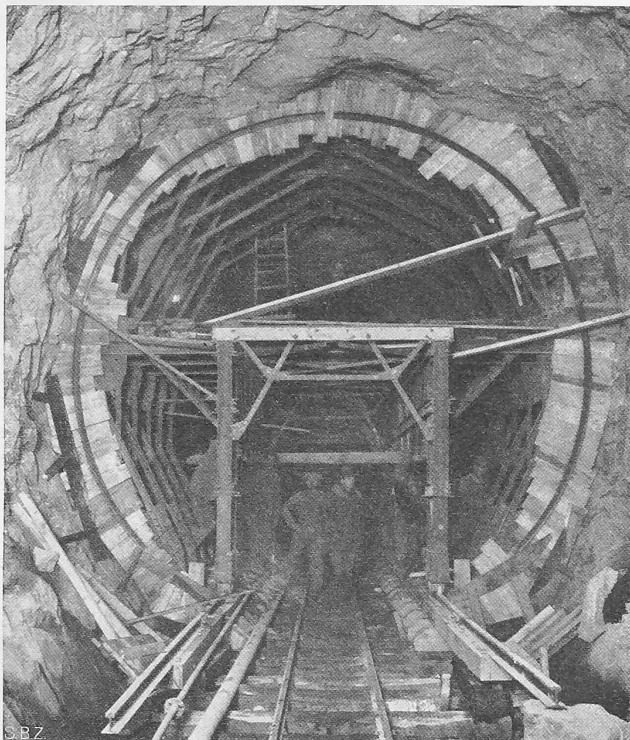
Abb. 13. Eiserne Schalung System Blaw-Knox.
