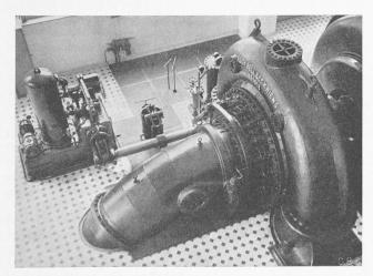
Abb. 8. Spiralfrancisturbine der A.-G. Th. Bell & Cie. (Kriens) für die Zentrale Unteraa des Lungernsee-Kraftwerks. 22 750 PS, H 203 m, 428 U/min.
