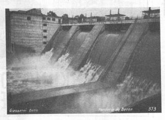
Stauwehr Wettingen, je vier Schützenwindwerke von je 100 resp. 30 Tonnen Tragkraft per Oeffnung
