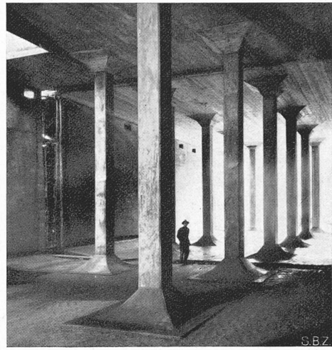
Abb. 3. Das Innere des Behälters von 8000 m³ Inhalt.
