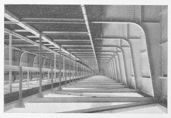
Abb. 4. Blick in das Brückeninnere, unter der Fahrbahn.
