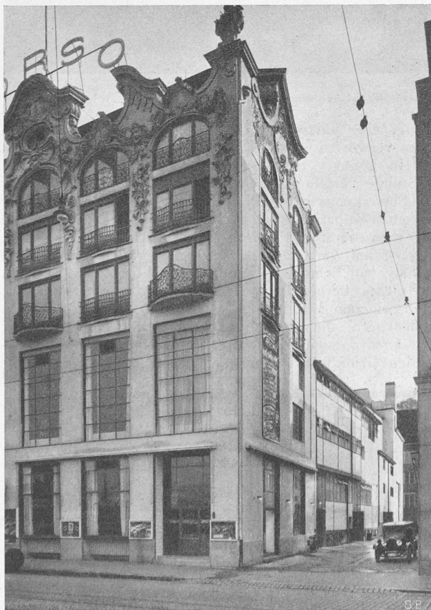
Abb. 1. Heutige Ansicht der Strassenfront des Corso-Theaters.
