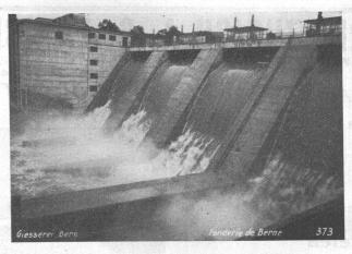
Stauwehr Wettingen, je vier Schützenwindwerke von je 100 resp. 30 Tonnen Tragkraft per Oeffnung.
