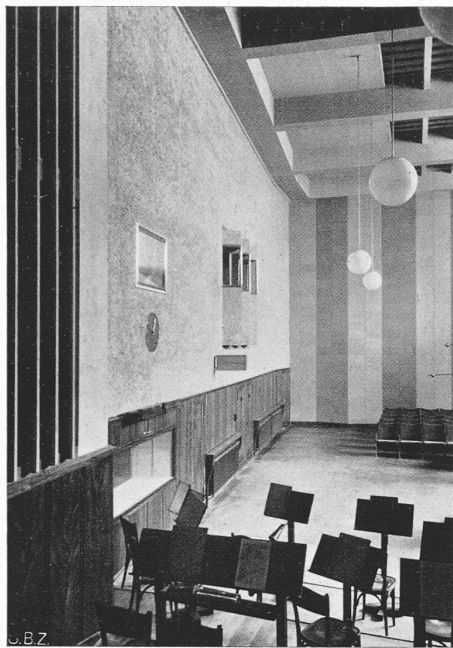
Abb. 8. Links Orgeljalousien; Dämpfungs-Rückwand.
