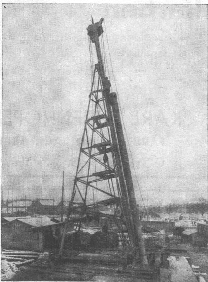
Verwendung von Stahldrahtseilen in Rammen.
