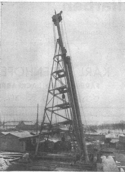
Verwendung von Stahldrahtseilen in Rammen.
