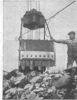
Verwendung von Stahldrahtseilen in Greifbaggern.
