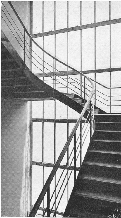
Abb. 19 und 20. Geschweisste Stahlblech-Nebentreppe (mit Gummibelag) und Korridor-Kopflicht,
