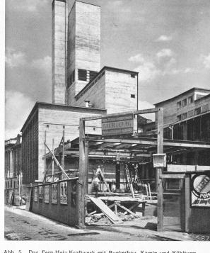
Abb. 5. Das Fern-Heiz-Kraftwerk mit Bunkerbau, Kamin und Kühlturm, im Vordergrund das Werkstattgebäude im Bau.
