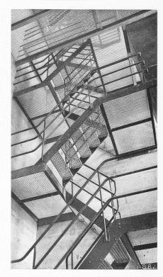
Abb. 19 und 20. Geschweisste Stahlblech-Nebentreppe (mit Gummibelag) und Korridor-Kopflicht,
