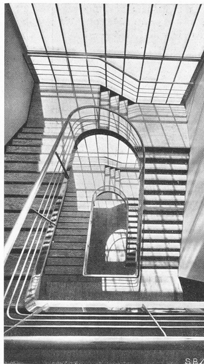
Abb. 19 und 20. Geschweisste Stahlblech-Nebentreppe (mit Gummibelag) und Korridor-Kopflicht,
