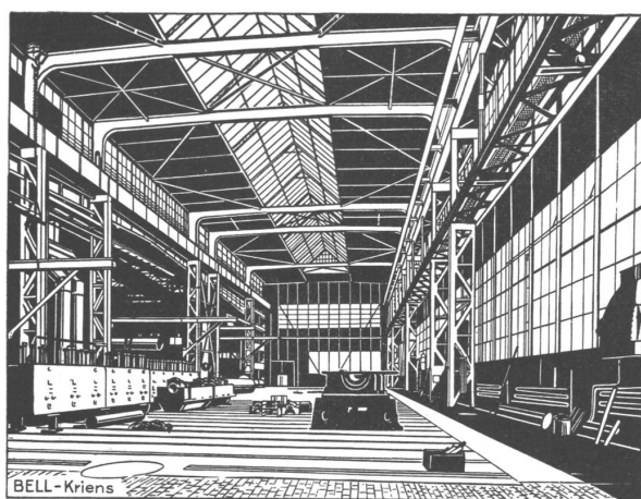
Grossmontagehalle, erstellt für die Firma Gebr. Sulzer A.-G., Winterthur. Länge 100 Meter, Breite: 30 Meter, Kranbahnhöhe: 18 Meter, Gewicht der Eisenkonstruktion: 613 Tonnen.
