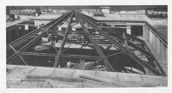
Abb. 9. Tragkonstruktion der "Kuppel"-Verglasung.
