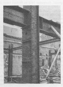
Abb. 17. Lichthofstütze, max. Belastung 580 t.
