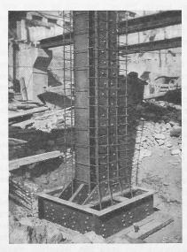
Abb. 19. Innenstütze mit Ummantelungs-Armierung.
