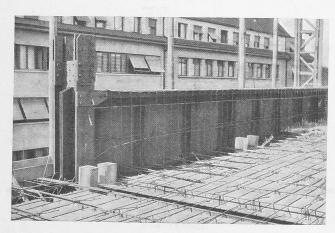
Abb. 12. Elektrisch geschweisster Blechträger für 126 t Last, Spannweite 12,0 m.
