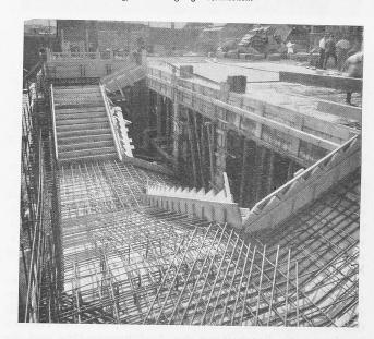
Abb. 11. Armierung der Haupttreppe in Eisenbeton.
