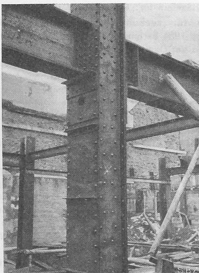
Abb. 17. Lichthofstütze, max. Belastung 580 t.
