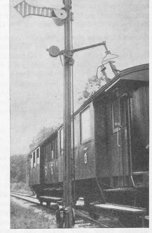
Abb. 3. Rein mechanisches System Kofler.
