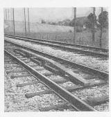
Abb. 4 und 5. Elektro-mechanische Zugsicherung ("Krokodil").
