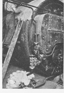
Abb. 2. Glasseide-Isolierung eines Dampfkessels im Claridge-Hotel in London.
