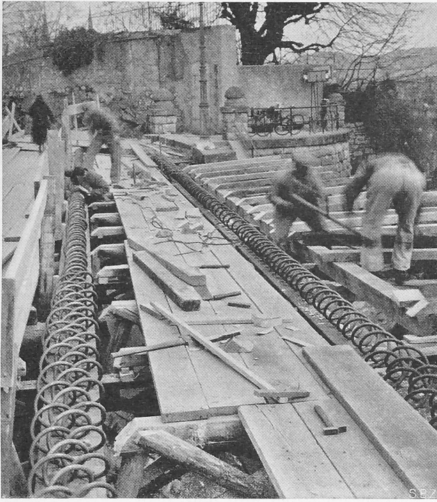
Abb. 3. Verstärkung der Jägerbrücke über die Bahnlinie Biel-Sonceboz.
