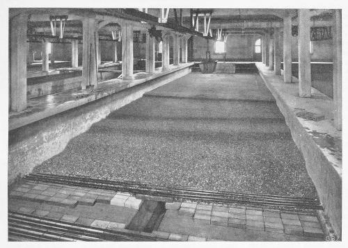
Abb. 1. Vorfilter eines offenen Langsamfilters mit Rohrnetz zur Rückspühlung und Durchlüftung. 15 cm Grobsand  $\oslash$  2 bis 4 mm, darüber 12 cm Feinsand  $\oslash$  0 bis 2 mm, Wassertiefe 50 cm. Filteranlagen der Stadt Zürich, im Moos-Wollishofen; vollendet 1914.1)
