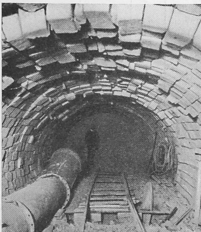
Abb. 18. „Fassdauben“-Einbau im Richtstollen.
