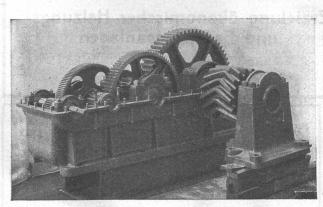
Maag-Getriebe z. Schwenken einer Hebebrücke, Zuiderzeewerke (Holland), 41 PS; 450/2,65 Umd./Min. (Grösste Hebebrücke in Europa.)
