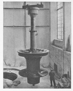
Abb. 4. Einbau eines Laufrades samt Turbinendeckel.
