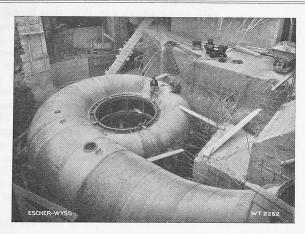
Abb. 5. Spiralgehäuse in Montage im Kraftwerk Wettingen.
