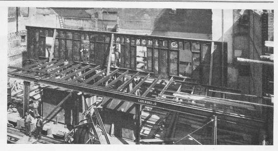
Abb. 7. Ansicht des fertig montierten 3,73 m hohen Wandträgers von 19,76 m Stützweite.
