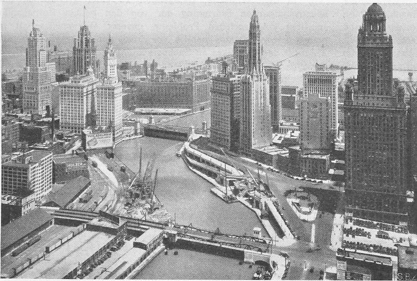
Abb. 2. State Street- und Michigan Av.-Brücken über den Chicago River, gegen Osten
