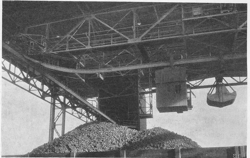
Abb. 3. Teilansicht des Laufkrans.
