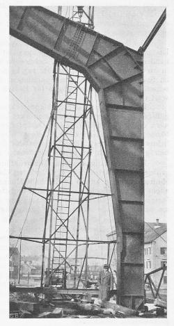
Abb. 3. Montage eines Binders.
