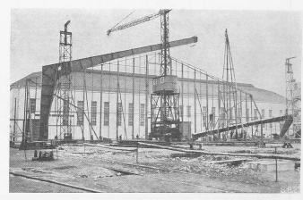
Abb. 4. Beginn der Binder-Montage; hinten Halle V.
