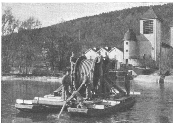
Verlegung von Hochspannungskabeln durch die Aare für das Elektrizitätswerk der Stadt Aarau.
